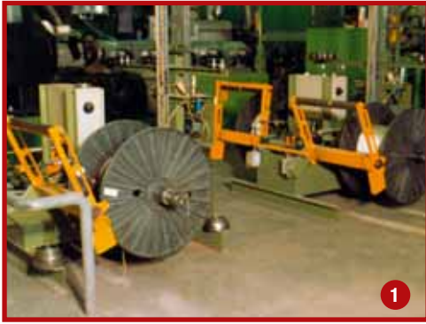
1 Kupferlitzen in diversen Querschnitten werden von den Transportrollen zuerst in den Extruder eingezogen
